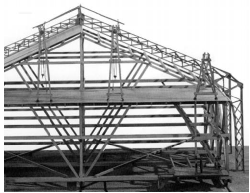
Echafaudage pour charpente métallique,
